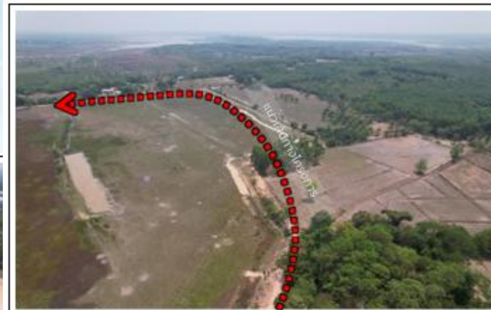
รูปที่ 6 สภาพพื้นที่ก่อนเสียดำเนินการเข้าถนนฝายกั้นน้ำของปึงหนองเงิน
