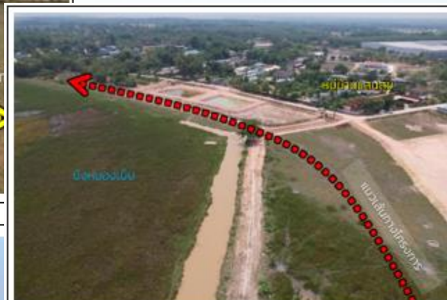
รูปที่ 4 สภาพพื้นที่บริเวณพื้นที่ชุ่มน้ำกุศสิงและแนวถนนใหม่บ้านแสนสุข
