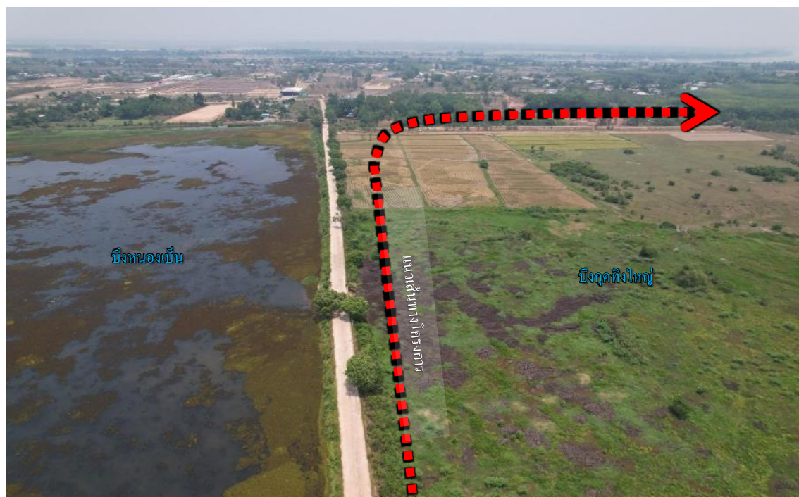
ภาพ Drone แนวถนนขนานกับถนนฝายกั้นน้ำของบึงหนองบัว
