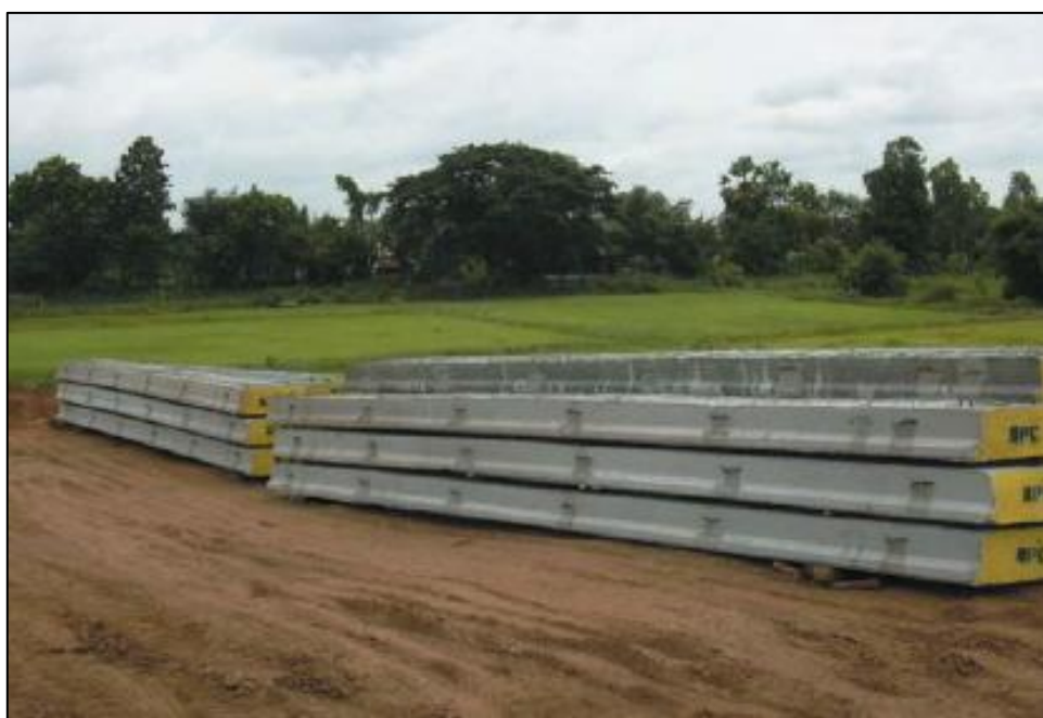
รูปที่ 6-12 ตัวอย่างรูปแบบโครงสร้างสะพานข้ามคลองขนาดเล็กช่วงไม่เกิน 12 เมตร (คานแบบแผ่นพื้นต้น : Plank girder)
