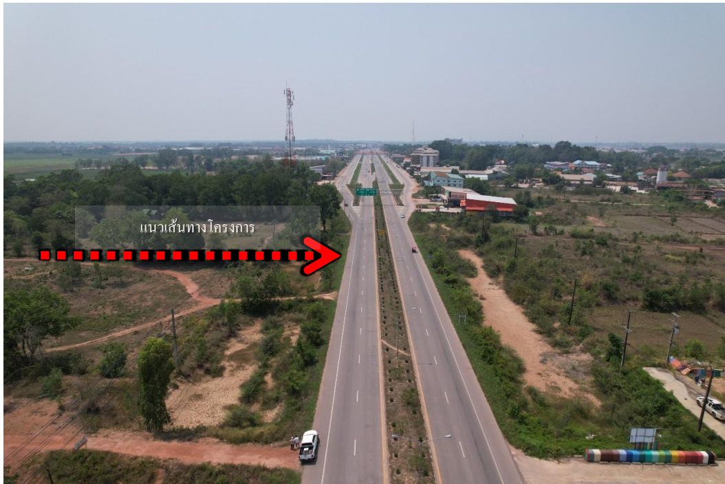
ทางหลวงหมายเลข 212 บริเวณหน้าศูนย์ราชการบึงกาฬ รูปที่ 5-1 สภาพพื้นที่ตามแนวเส้นทางโครงการ (ต่อ)
